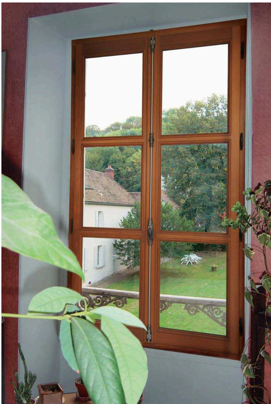
Dormant 63 mm assemblage mécanique vissé - Ouvrants 68 mm assemblage traditionnel à double enfourchement
