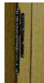
Paumelle turlupet à plaque vissée pour la fenêtre et le volet intérieur
